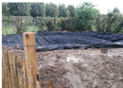
Étape 3 : pose du géotextile et d'une membrane
