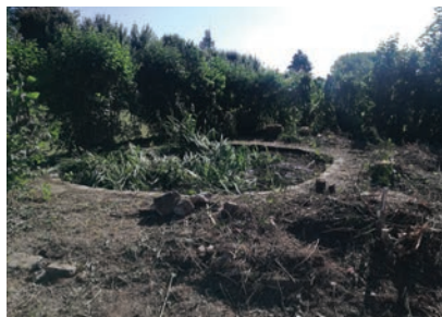
Étape 1 : travaux de démolition et d'excavation
