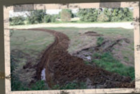
Pose de drains
